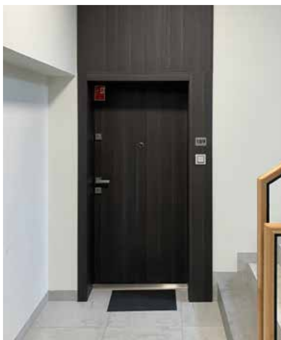
drzwi RC3, wzór W0, ościeżnica stała drewniana
