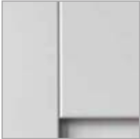
fazowanie krawędzi na połączeniu ramiaków
